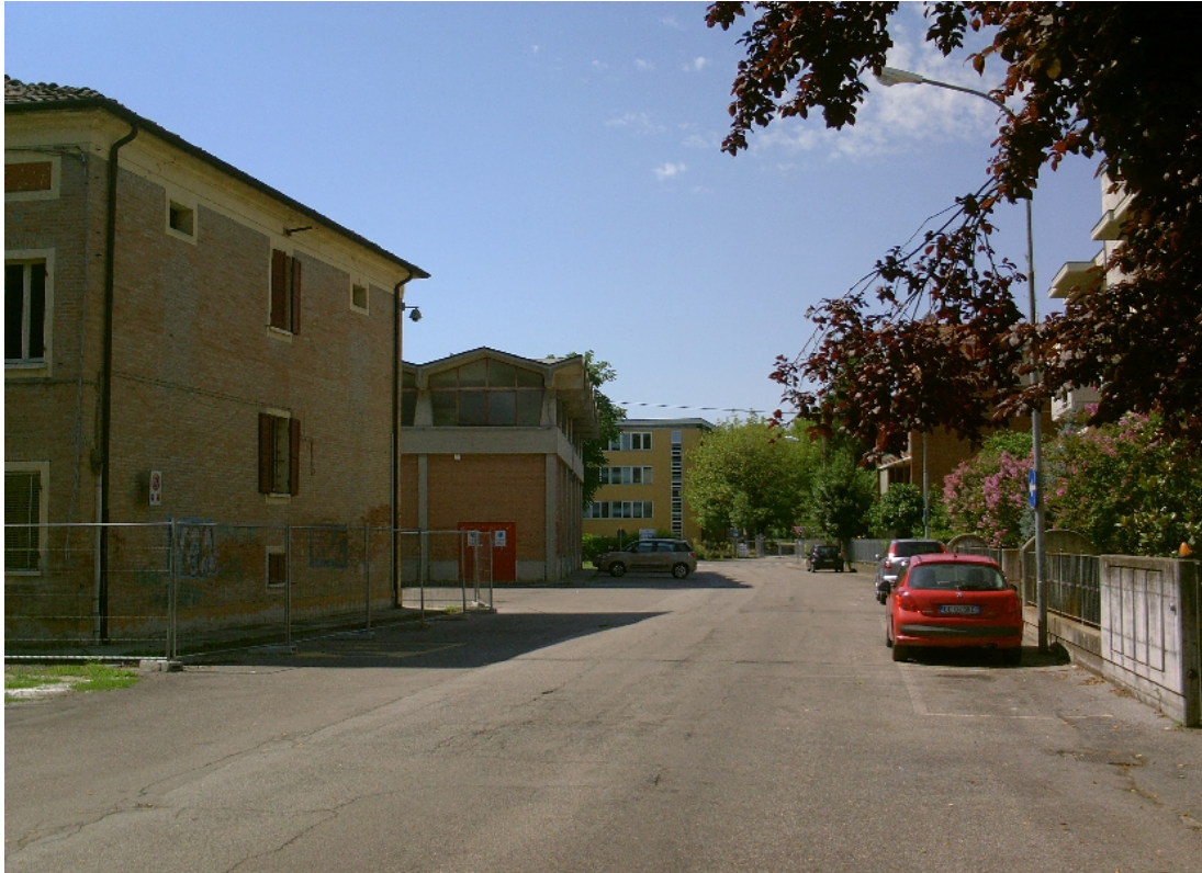
Lato strada via E.Fermi
