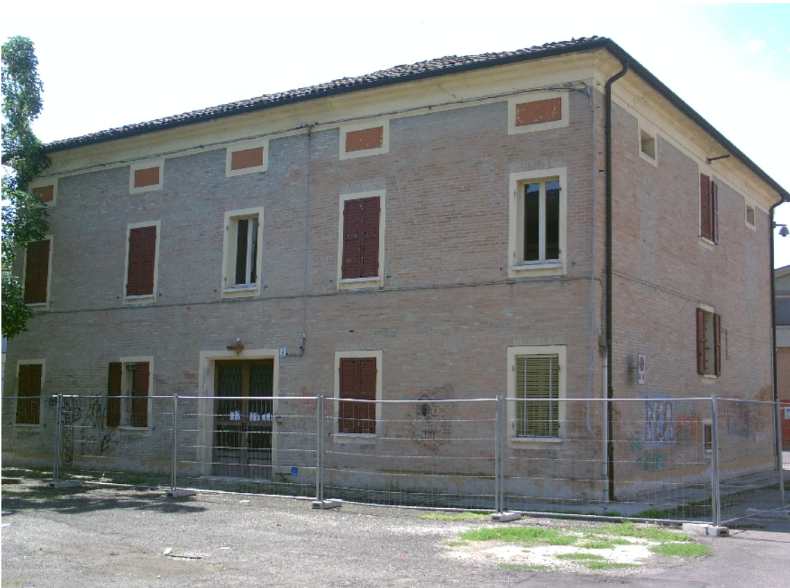
Fabbricato da demolire
