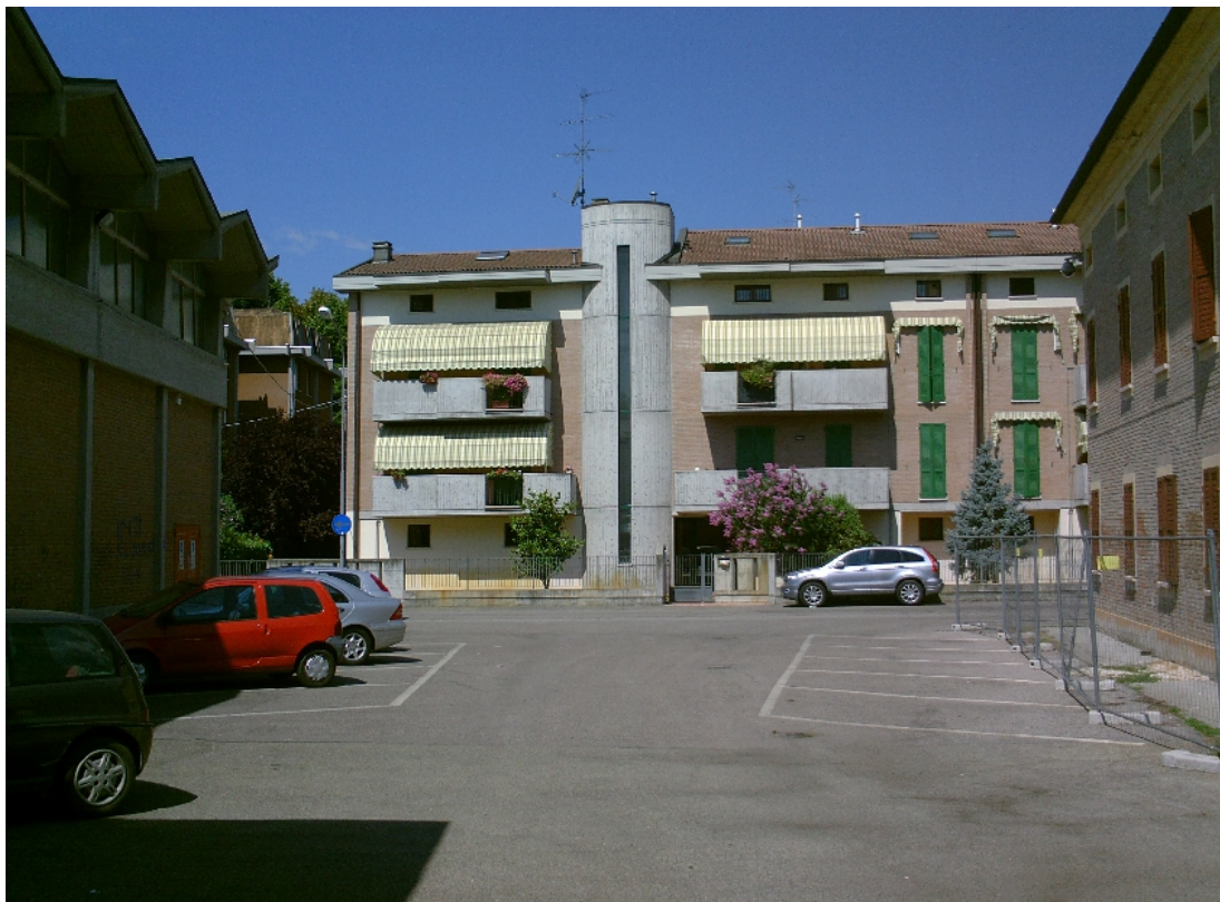
Lato Palestra (accesso mezzi per la demolizione)
